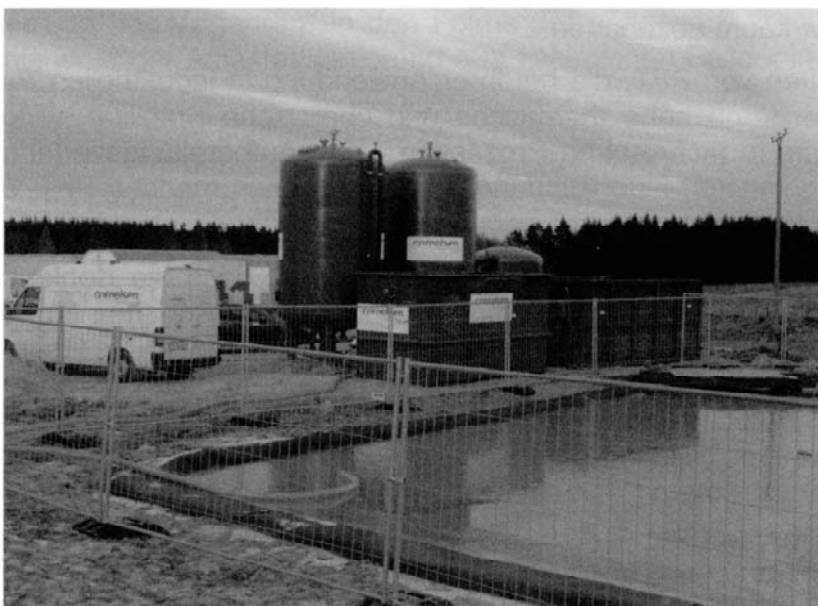
Abb. 1: Ad Hoc - Anlage für PFT-Schadensfall in Brilon-Scharfenberg (2006)
